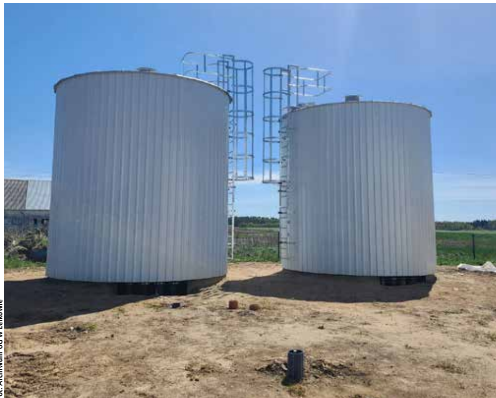
Trwają intensywne prace modernizacyjne przy stacji uzdatniania wody w Przebędowie – kluczowym obiekcie zaopatrującym w wodę 13 miejscowości w gminie Lelkowo
