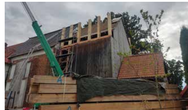
Prace obejmują m.in. wymianę dachu
