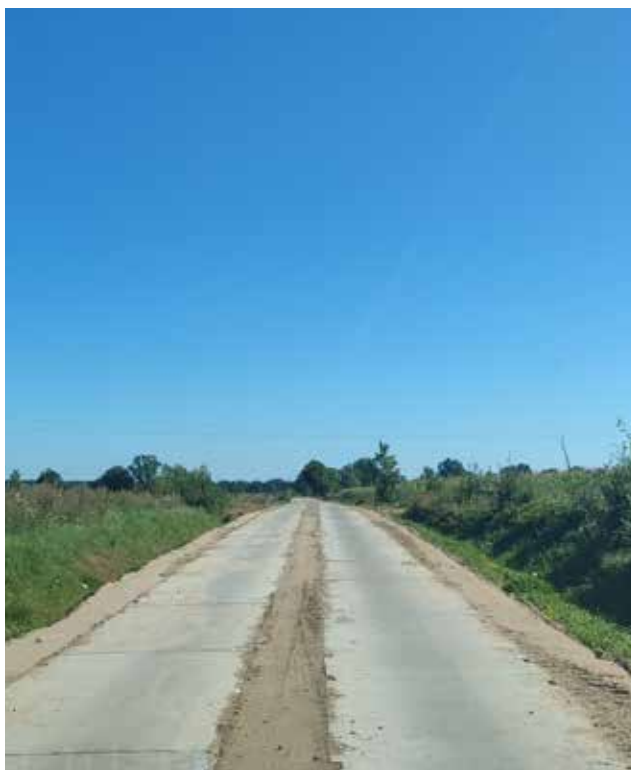
Droga w Starym Siedlisku – po przebudowie
