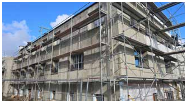
Termomodernizacja Miejskiego Domu Kultury obejmuje m.in. docieplenie budynku, wymianę instalacji oraz modernizację wnętrza
