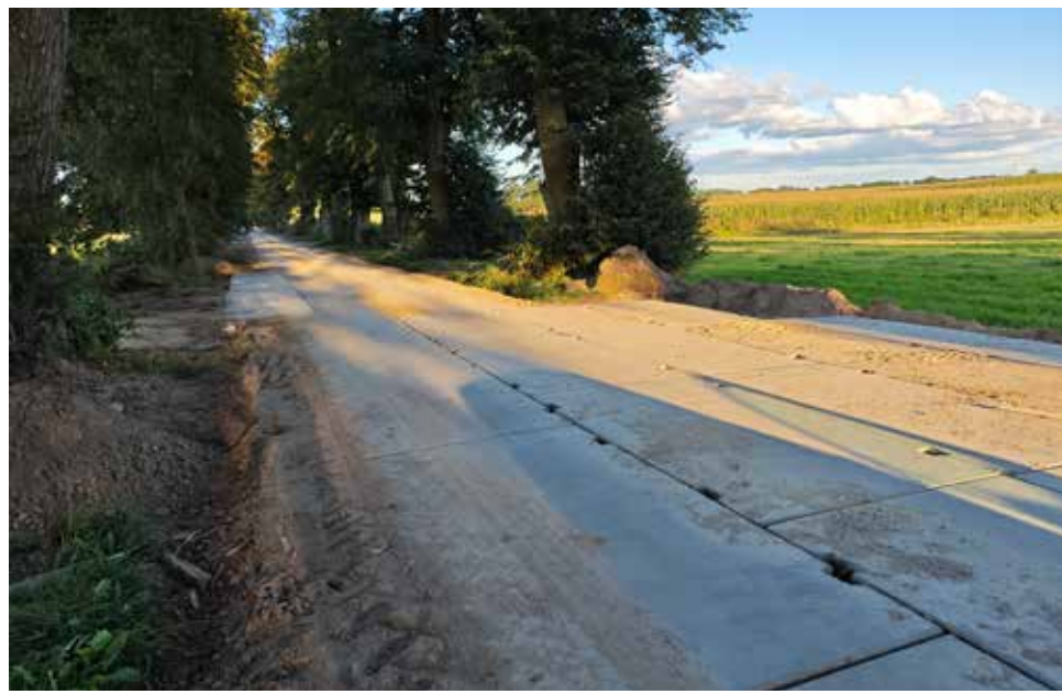
Droga w Ławkach – po wykonanych pracach
