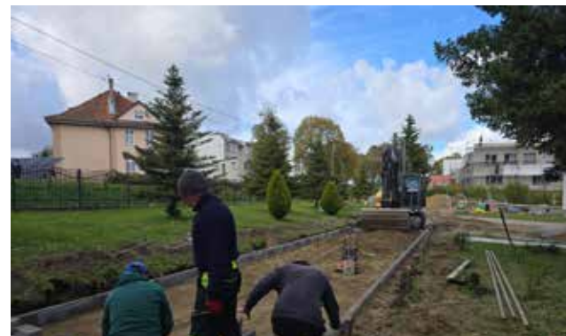
Trwa modernizacja ciągów pieszo-jezdnych przy MGOPS i ŚDS
