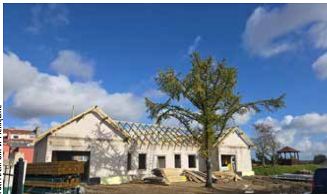
Trwa budowa żłobka, prace przebiegają zgodnie z harmonogramem
