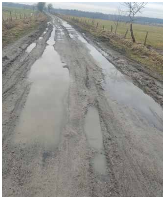
Droga w Starym Siedlisku – przed przebudową
