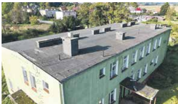
Budynek świetlicy w Zagajach
