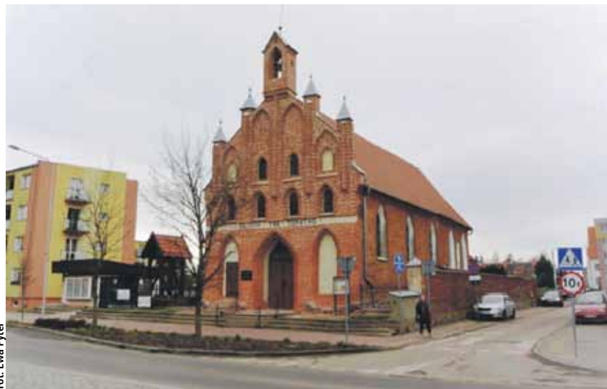
Zakończenie remontu to ważny krok w procesie przywracania świątyni jej dawnego wyglądu
