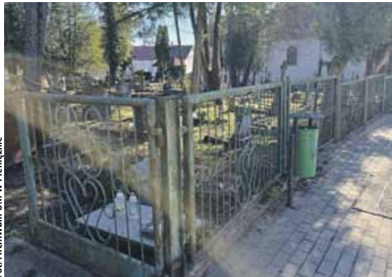
Ogrodzenie cmentarza przed wykonaniem prac
