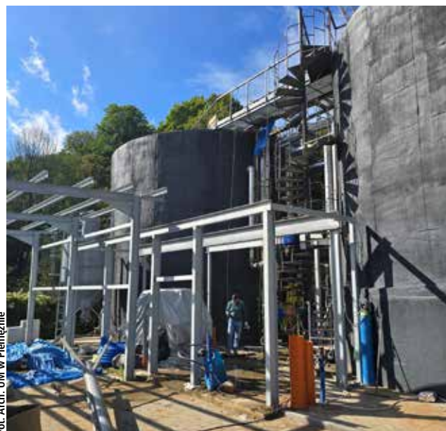
Zakończyły się już prace remontowe potężnych bioreaktorów, które odgrywają kluczową rolę w procesie oczyszczania ścieków
